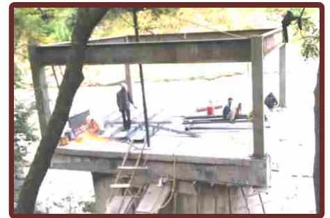
फोरेस्ट ऑफिस एस.टी.पी. निर्माण कार्य
