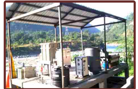
संगम मार्ग एस.टी.पी. निर्माण कार्य
