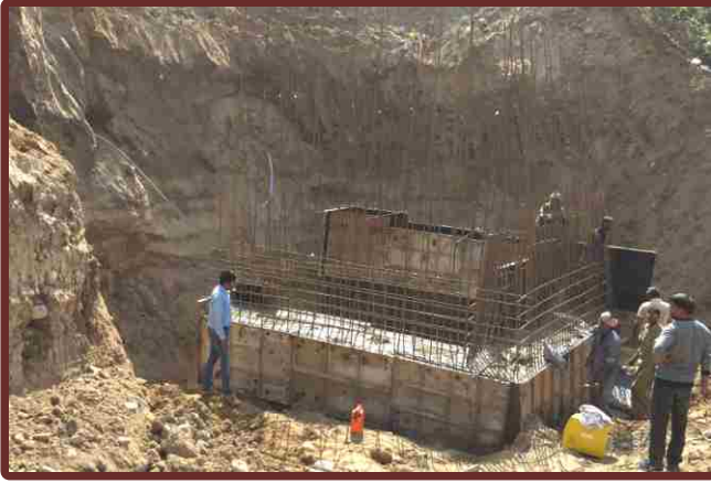
सिविल कार्य सिल्ट इजैक्टर चैनल पर 16 मीटर स्पैन का पुल
