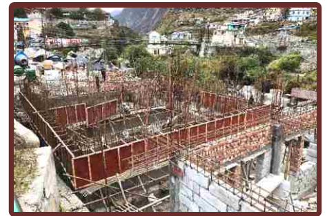
1.00 एम0एल0डी0 सीवेज ट्रीटमेंट प्लांट निर्माण कार्य
