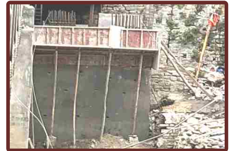
कैरियर लाईन हेतु स्टील ब्रिज एबटमेंट निर्माण कार्य
