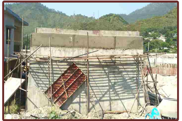
3.50 एम0एल0डी0 एस0टी0पी0 अपग्रेडेशन (Anoxic Tank/Aeration Tank/RSF)
