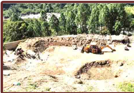
पोखरी बैण्ड एस0टी0पी0 सुरक्षा दीवार निर्माण कार्य
