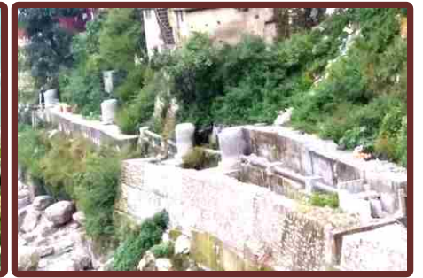
एलिवेटेड कैरियर लाईन एवं मैनहोल निर्माण
