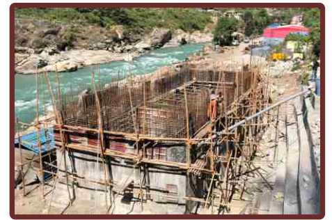
चमोली एस0टी0पी0 निर्माण कार्य
