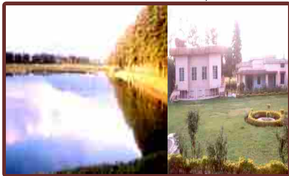
6 MLD STP (GAPI), LAKKARGAHAT(WSP)
