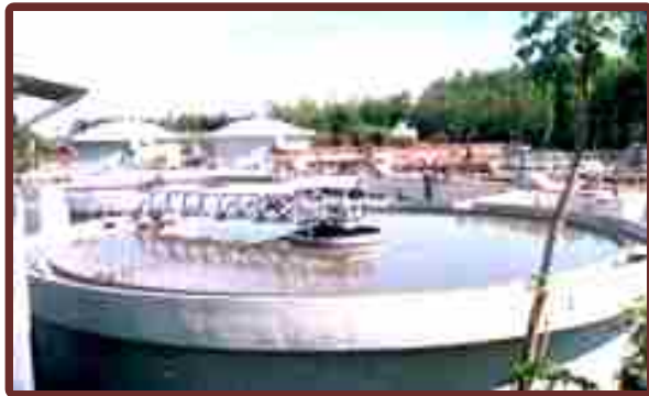
18 MLD STP (GAP-I), JAGJEETPUR ASP)
