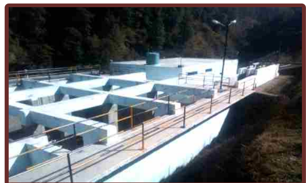
0.90 MLD STP KULARI, MUSSOORIE
