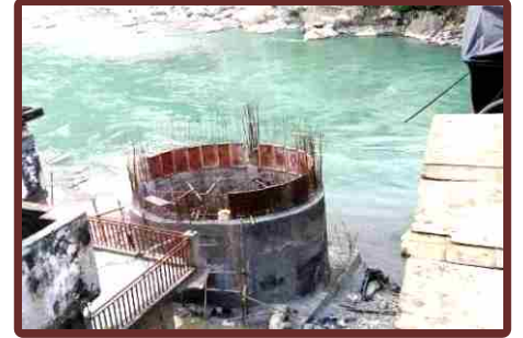
पुराना पुल (पी0डबल्यू0डी0) एस0टी0पी0 निर्माण कार्य
