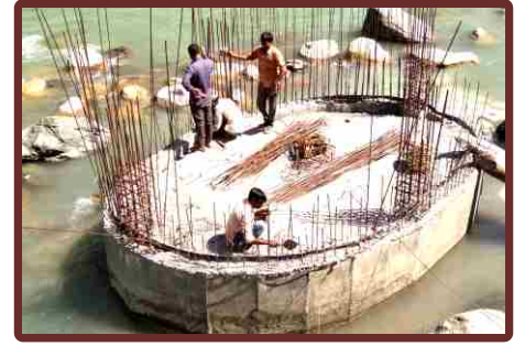
सुभाष नगर एस0टी0पी0 निर्माण कार्य
