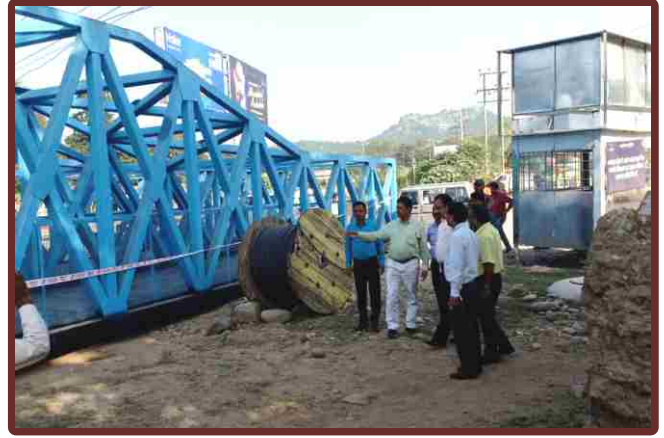
सिविल कार्य सिल्ट इजैक्टर चैनल पर 16 मीटर स्पैन का पुल
