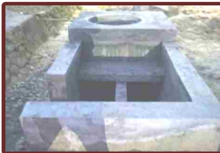
इन्टरसेप्सन स्ट्रक्चर निर्माण कार्य
