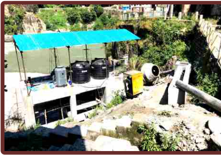
पुलिस चौकी एस0टी0पी0 निर्माण कार्य
