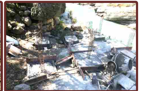
चमोली पुराना झूला पुल एस.टी.पी. निर्माण कार्य
